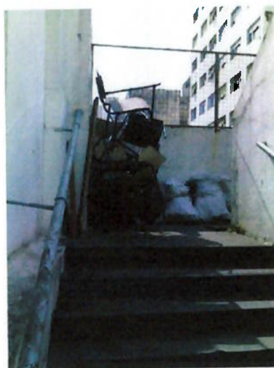
Figura 27 – Escada de rota de fuga obstruída
