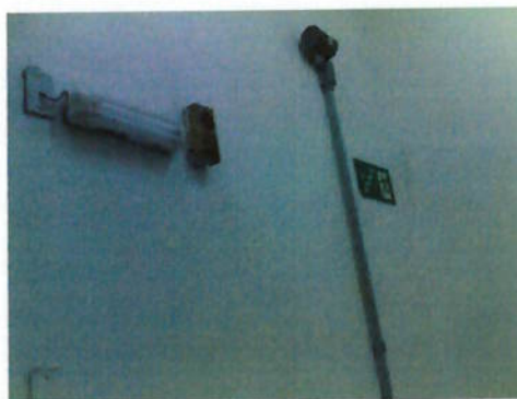
Figura 33 – Sirene, iluminação de emergência e indicação de rota de fuga. Fonte: GRC
