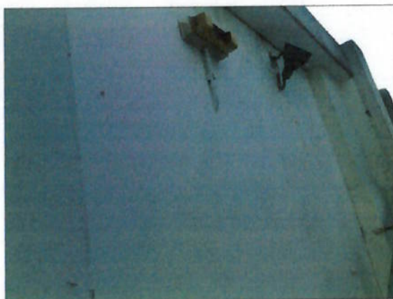
Figura 30 – Iluminação de emergência danificada na escada de rota de fuga. Fonte: GRC
