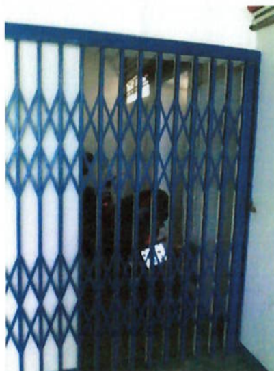
Figura 29 – Portão de saída de emergência com cadeado e obstruído com moto. Fonte: GRC
