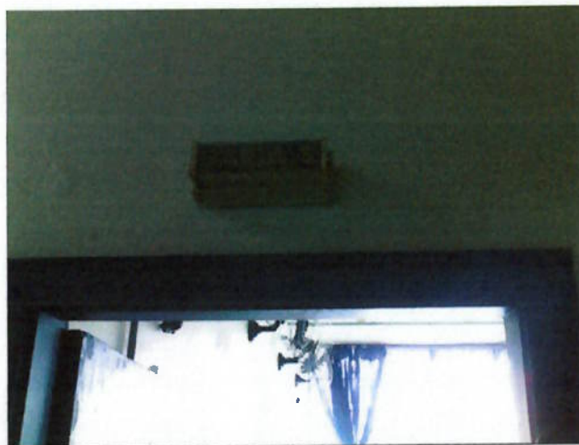
Figura 31 – Iluminação de emergência sem manutenção. Fonte GRC
