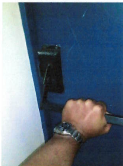
Figura 19 – Porta corta fogo trancada. Fonte: GRC
