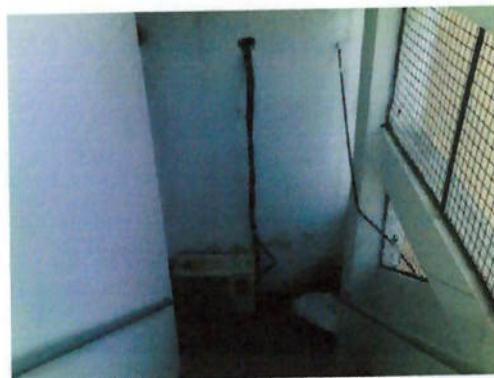
Figura 26 – Rota de fuga obstruída por aparelho condicionador de ar. Fonte: GRC
