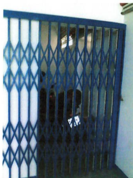
Figura 25 – Rota de fuga ocupada com moto e trancada a cadeado. Fonte GRC
