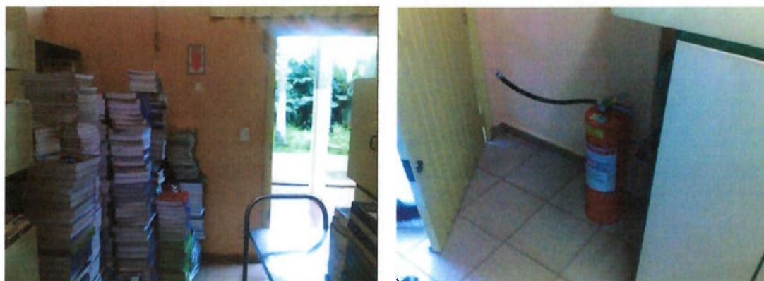
Figura 20 – Extintor fora de local. Fonte: GRC
