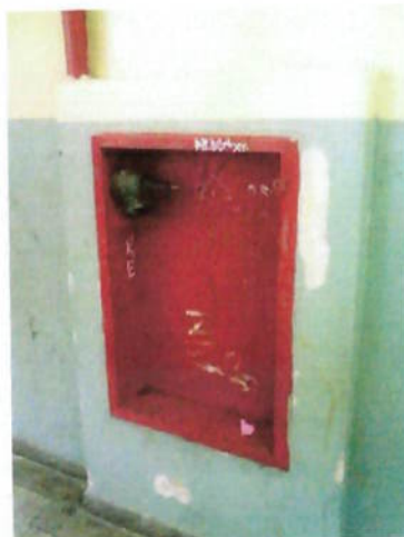
Figura 23 – Abrigo de hidrante em escola pública inutilizado. Fonte: GRC
