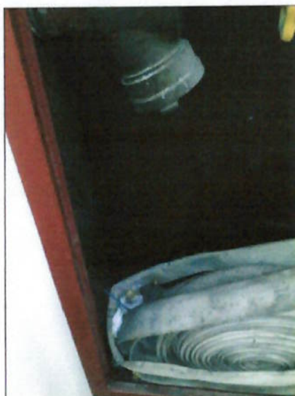
Figura 22 – Abrigo de hidrante com lixo. Fonte: GRC
