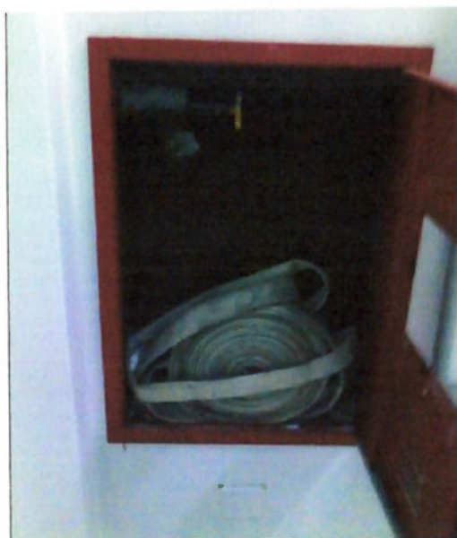
Figura 21 – Abrigo de hidrante com mangueira enrolada e suja . Fonte: GRC
