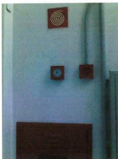
Figura 32 – Botoeira de alarme e acionamento de bomba. Fonte: GRC
